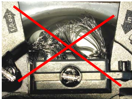
Prise TV mal raccordée
